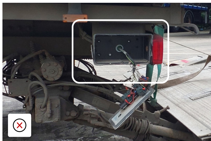
Udvendig liftkontakt smadret - kræver udskiftning
